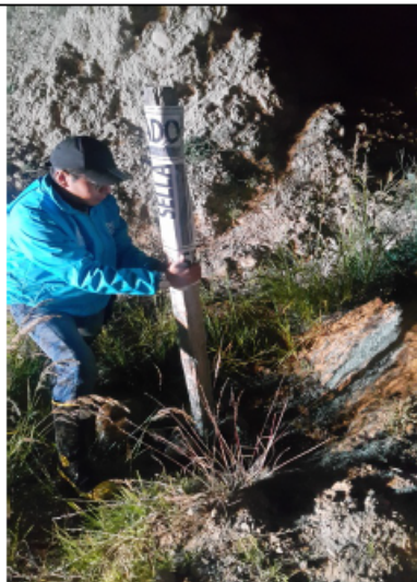
Fotografía 13 Punto de salida de las piscina de finos
